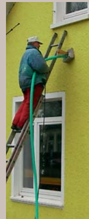
Abbildung zeigt: Einbau des Dämmstoff
