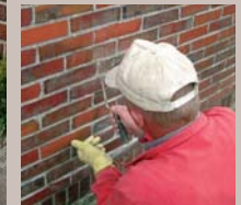
Abbildung zeigt: Einsetzen der Steine
