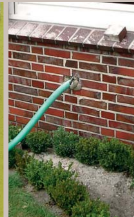
Abbildung zeigt: Einbau des Dämmstoff unter dem Fenster
