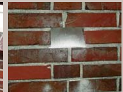
Abbildung zeigt: Eingebauter Zustand (kein Nachsacken)
